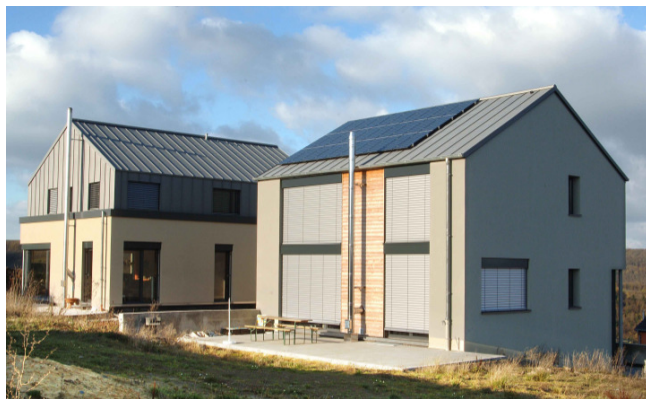
Volumétries sobres : Quartier Neitwunnen à Putscheid
