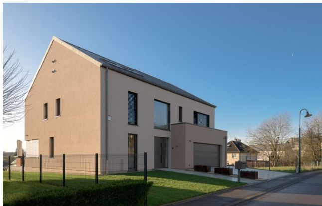
Volumétries sobres : Leudelange
