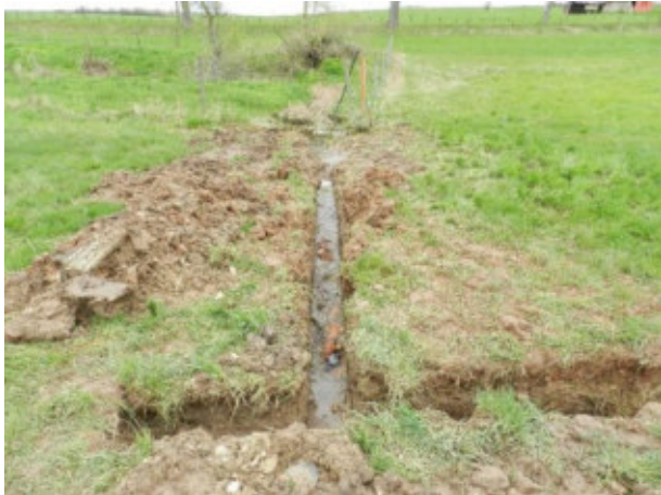
Abbildung 10: Blick auf den Oberflächenwasserkanal von der N22, über die westlich des Plangebietes bestehenden Privatteiche in Richtung der südlich verlaufenden Attert. Aufgrund eines Rohrbruches wurde dieser Bereich offengelegt (links). Blick in westliche Richtung auf die freie Wiesenfläche westlich des Plangebietes (rechts). Quelle: CO3, 2017
