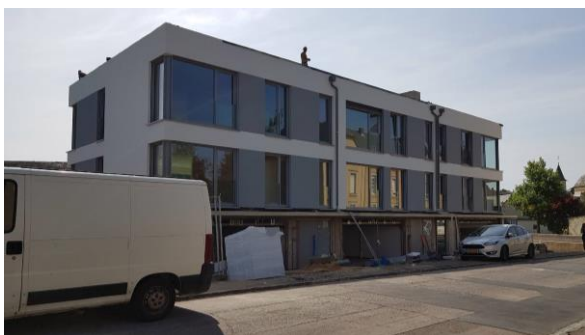
Figure 10 : Résidence en construction à proximité du centre
