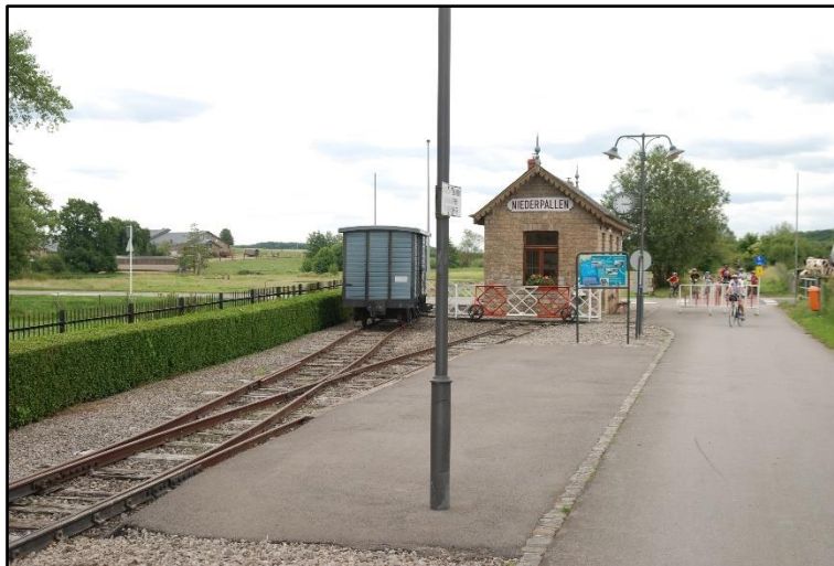
Blick auf das ehem. Bahnhofsgebäude
