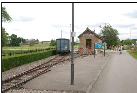
Blick auf das ehem. Bahnhofsgebäude
