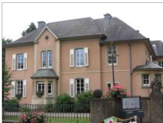
Abb.3: Blick auf das Herrenhaus an der „Rue de Reichlange“, das als Verwaltungssitz dienen soll. Quelle: CO3 2005
