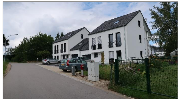
Abbildung 8: Blick auf die Gebäude 1A und 1B, Auf Frohn als Teil des PAP „Auf Klapescht“. Quelle: CO3 2020
